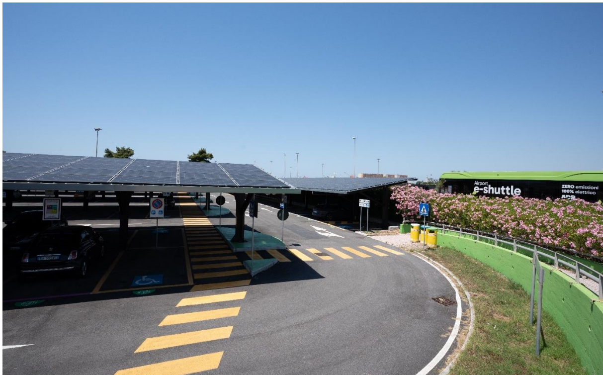
Pensiline fotovoltaiche parcheggio Lunga Sosta
